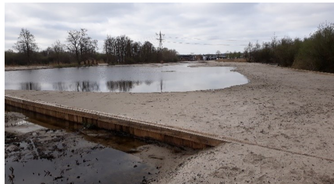
Foto: De saneringslocatie ketelweg direct na het afgraven van de vervuiling.
