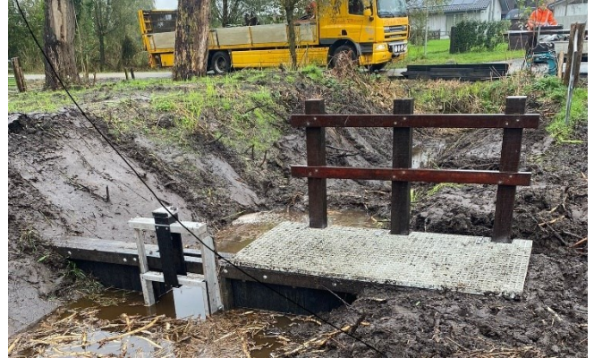
Foto: aanleg van een nieuwe stuw bij de Grebbeweg.
