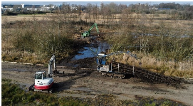
Foto: verwijderen van boomopslag en afvoeren van hout in de Blauwe Hel.
