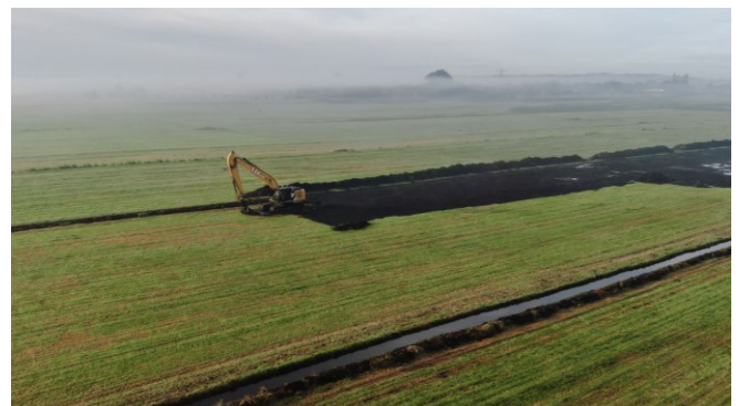
Foto: Plaggen; het afgraven van de toplaag met gras.
