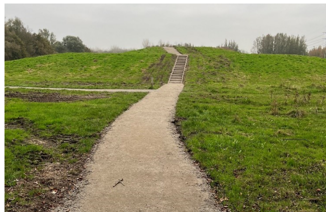
De herstelde trap en opgeknapt pad bij de uitkijpheuvel
