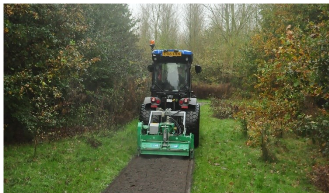
Door het frezen worden de betonpaden weer egaal.
